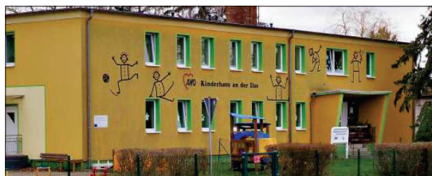
85 nahezu ausgebuchte Plätze bietet das „Kinderhaus an der Ilse“. Da der Keller feucht ist und nicht auf Dauer nutzbar ist, soll ein Erweiterungsbau entstehen.
